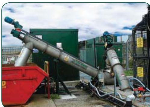
Auger Monster и поперечный конвейер.
